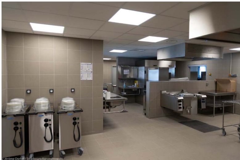
Rénovation du Groupe scolaire Finkwiller et de son restaurant
