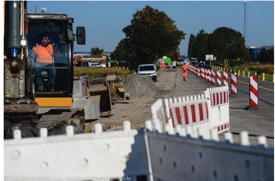
Lancement des travaux du tram vers l'Ouest
