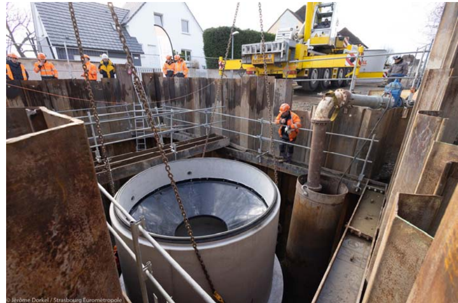
Eschau : pose de décanteurs pour la protection du milieu naturel
