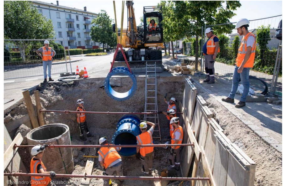
Nouvelle conduite d'eau rue du Languedoc
