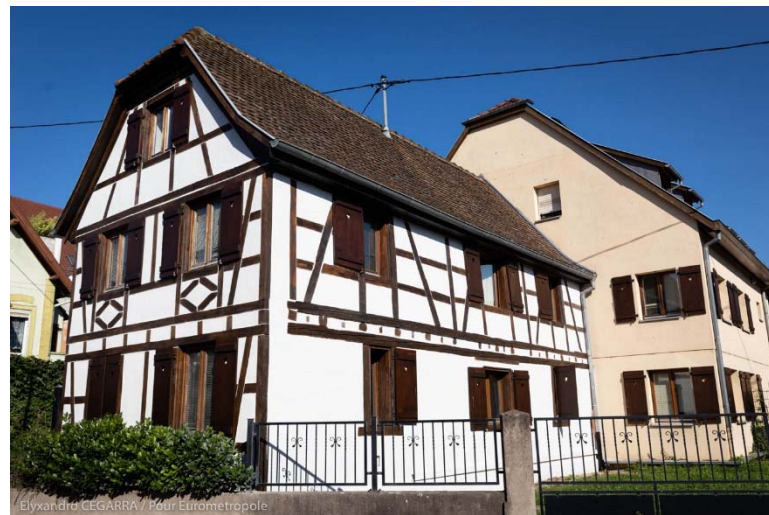
Rénovation énergétique de l'annexe de la Mairie de Hoehnheim
